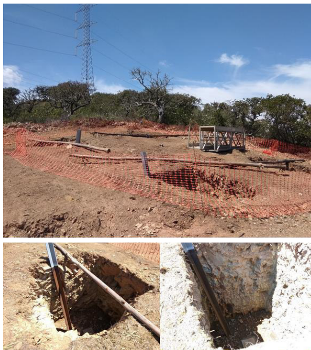
Fundações dos apoios
